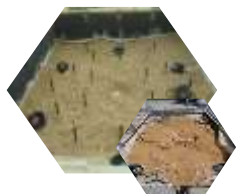
Instalaciones piloto de electro-remediación
